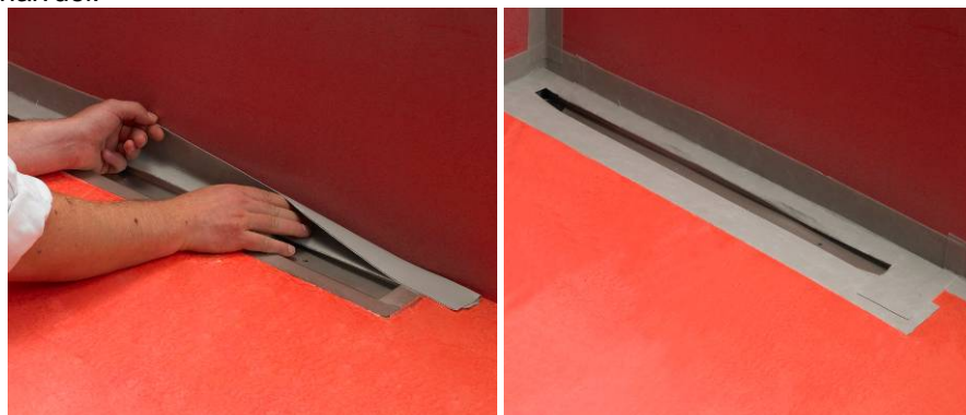
4. Montering af Seal-Strip
