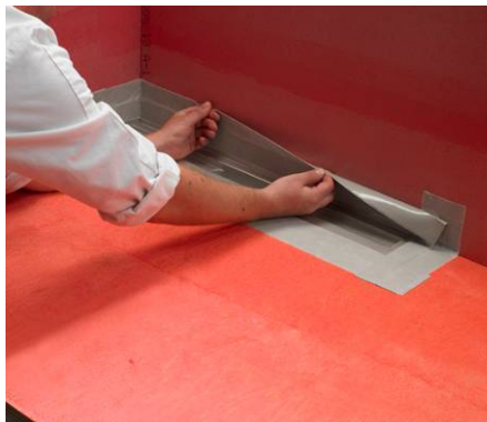
4. Montering af Seal-Strip
