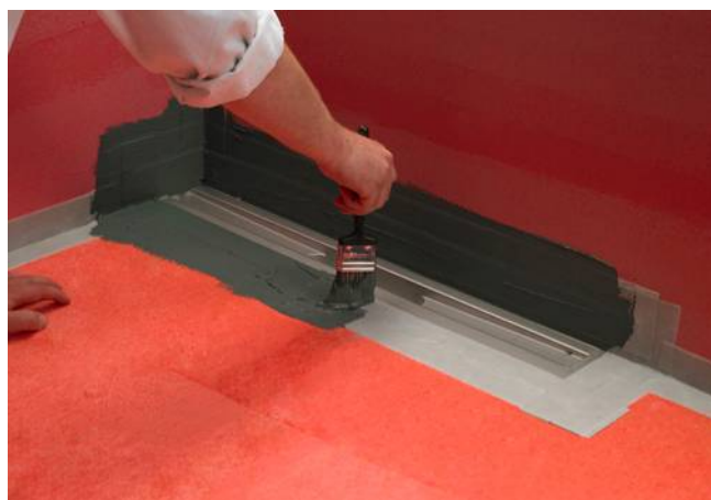
5. Påføring af Alfix Tætningsmasse
